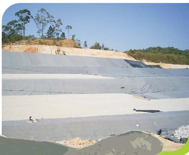
O Geotêxtil não-Tecido Geosolutions é um produto desenvolvido para auxílio em obras geotécnicas para as funções de renagem, filtração, proteção, reforço, separação.
